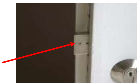
Un pêne long à double ou triple tour est toujours préférable
