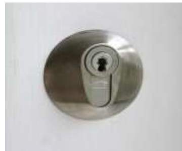
Serrure de sécurité munie d'une rosace affleurante fixée de l'intérieur (photo BKS)
