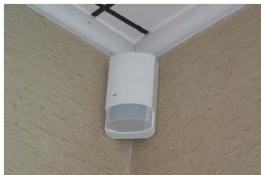
Detector met dubbele technologie (bijv. infrarood + radar)
