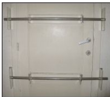
Een of meer stevige deurstangen aan de binnenkant van de deur... (foto's STOP VOL)
