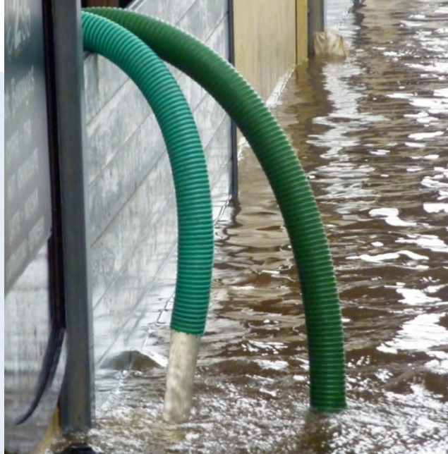
Barrière anti-inondation étanche avec système de pompage dans la zone protégée
