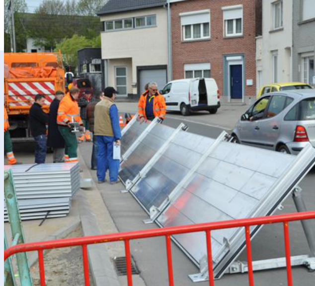
Test d'une barrière d'urgence anti-inondation par les services communaux de Grammont
