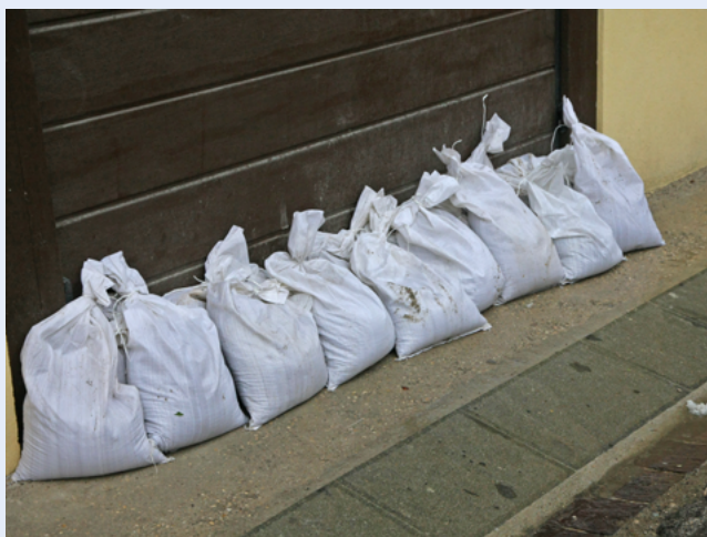
Zandzakjes aangebracht vóór de komst van het water
