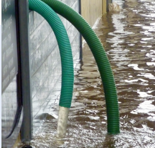
Waterdichte anti-overstromingsbarrière met pompsysteem in de beschermde zone
